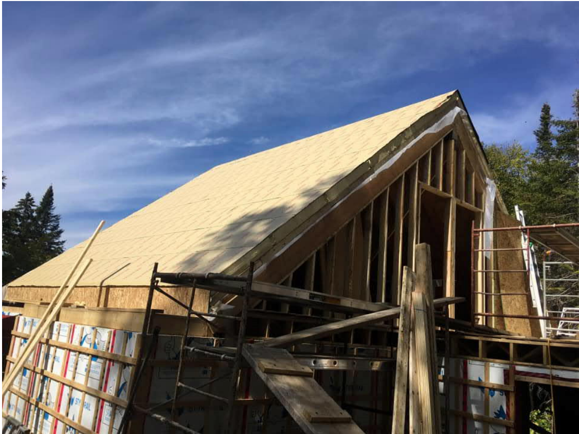
Toiture couverte de membrane et prête à recevoir les 2x6 sur le périmètre.
