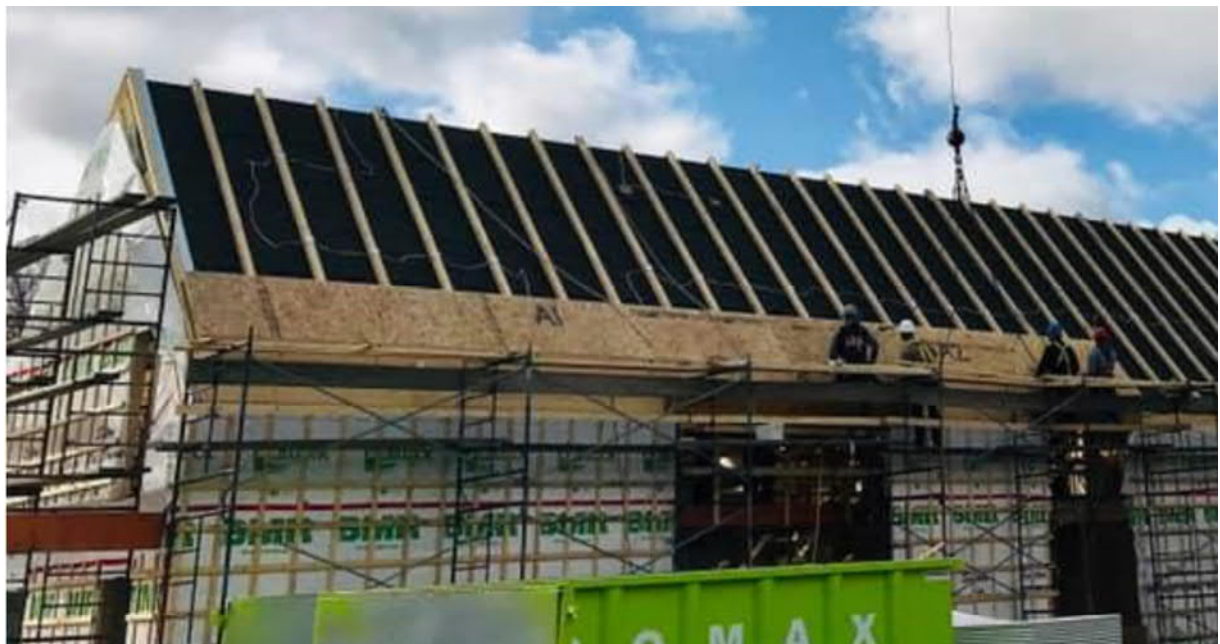
Installation de la première rangée de panneaux.
