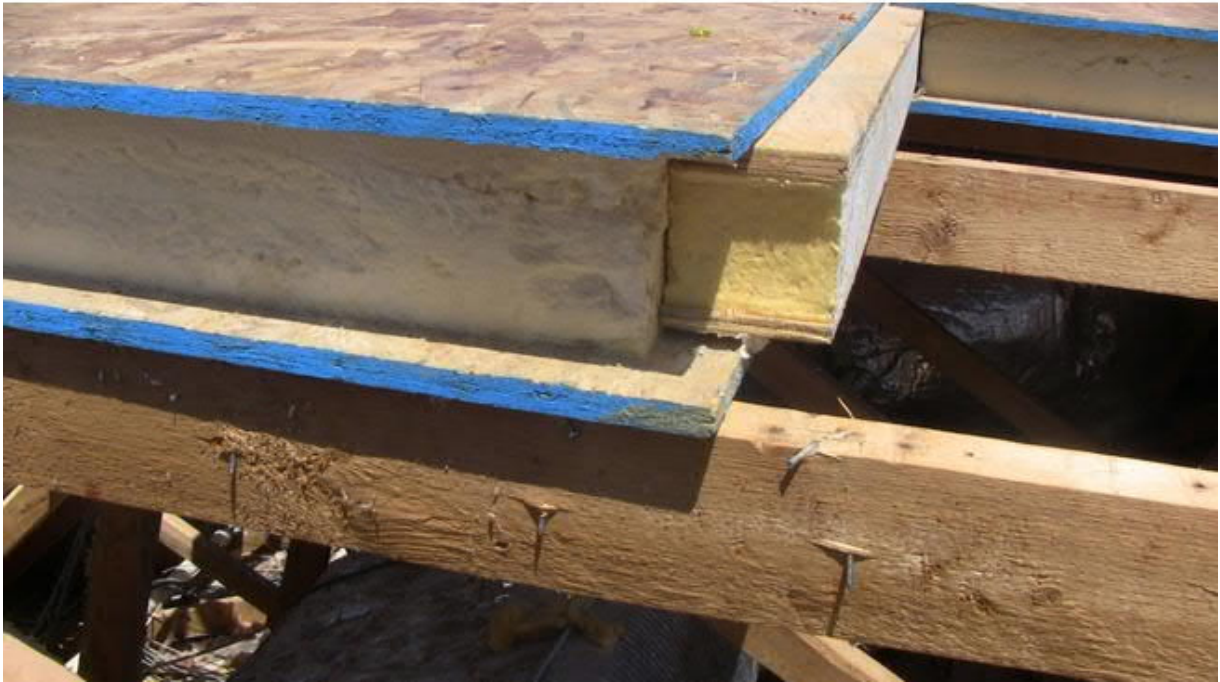
Jonction de panneau toiture ou plancher.
