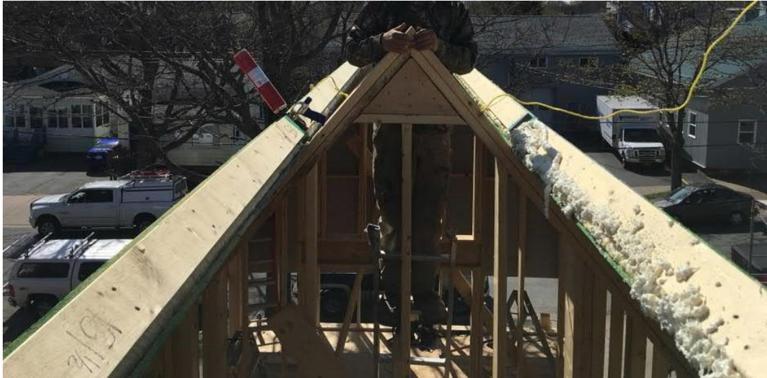
Toiture rendu à la pointe prête pour recevoir le pignon.
