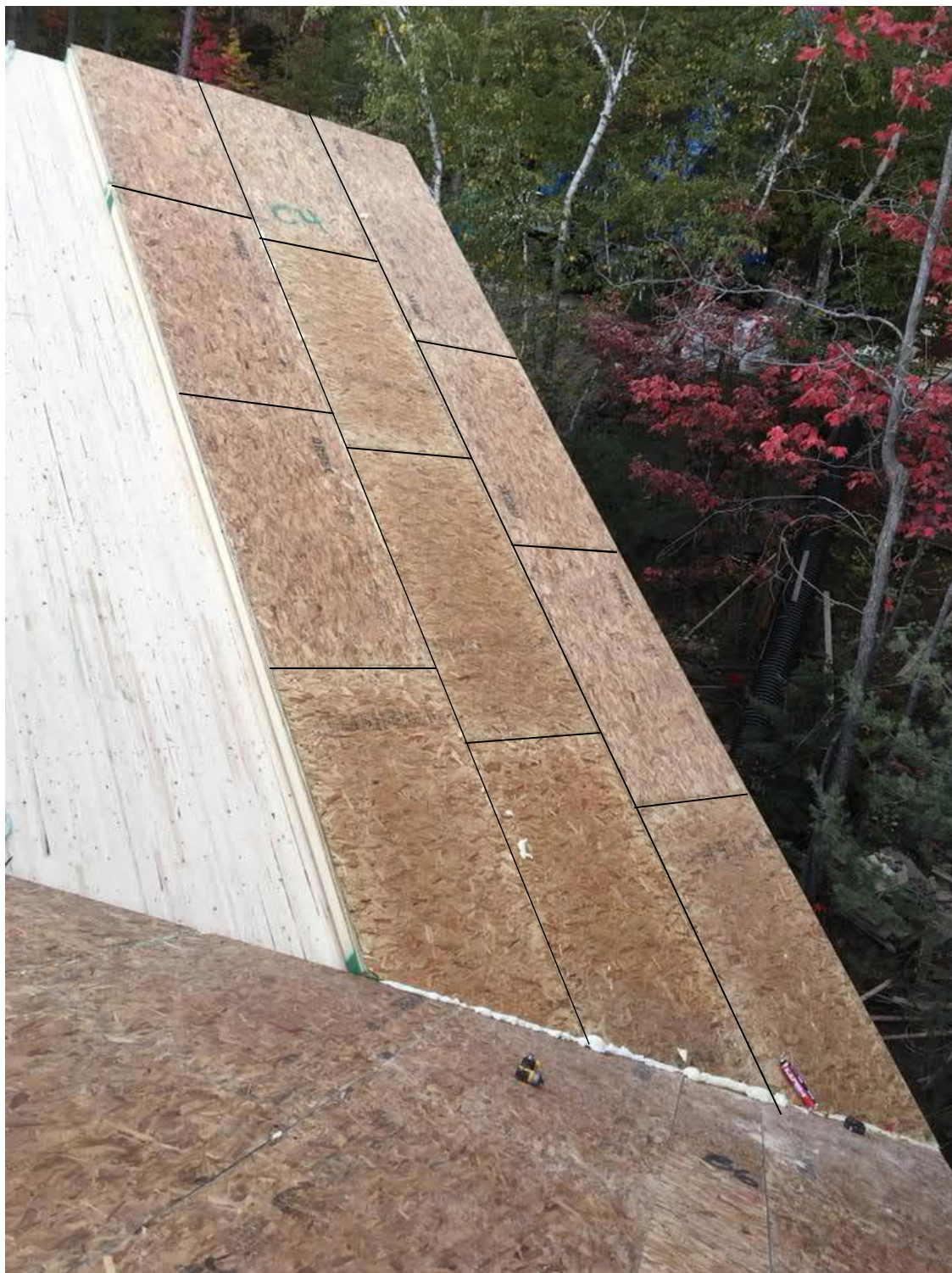
Section de panneaux installés perpendiculairement.
